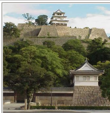
石垣の美・現存木造天守で 名高い丸亀城
